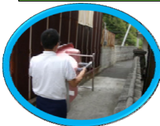
④浴槽を搬入させていただきます。
