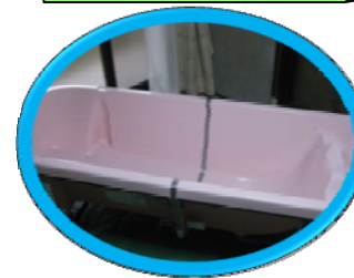
⑤浴槽を組み立て、給湯開始。
